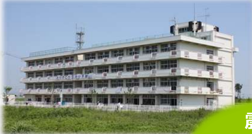
震災遺構仙台市立荒浜小学校
