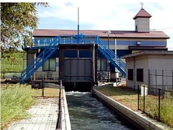
利根大堰から取水する。大分水工で180度向きをかえ、利根大堰上流の河床下をφ1600の鋼管を通り揚水、北に流れながら利根川を伏越で交差し、利根川左岸を平行するように東へ向きを流れ、流域の周囲を灌漑する。大堰から東へ流れる利根加用水もある。いくつかの用水路を分岐し随所に設けられた調節堰を通過しつつ利根川の左岸を並行して流れ千代田町、明和町、板倉町を経て埼玉県加須市（北川辺地区）に至り終点となる。
