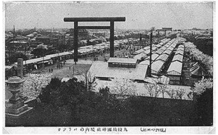
◎靖国神社に設置された仮設住宅
