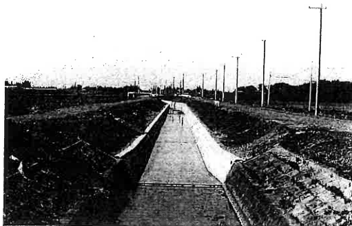
櫛挽排水路（完成後・深谷市境地区）
