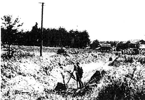
荒川放水路工事（昭24）
