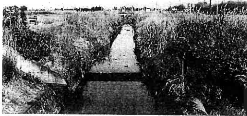
櫛挽排水路（着工前・深谷市境地区）
