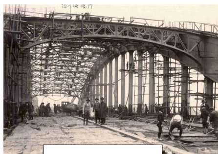
建設中の永代橋
