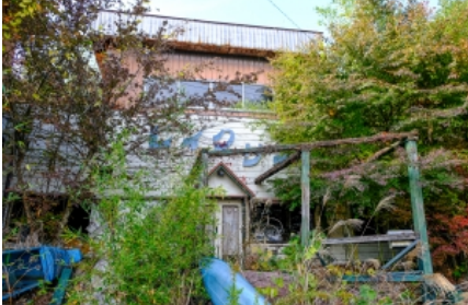
多野鉱山(現在廃墟)
