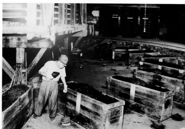
ホフマン輪窯の2階からの給炭 <日本煉瓦製造(株)所蔵>
