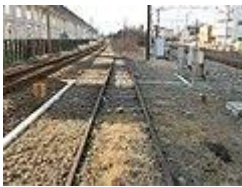
秩父鉄道併用区間に残された旧熊谷線の線路。
