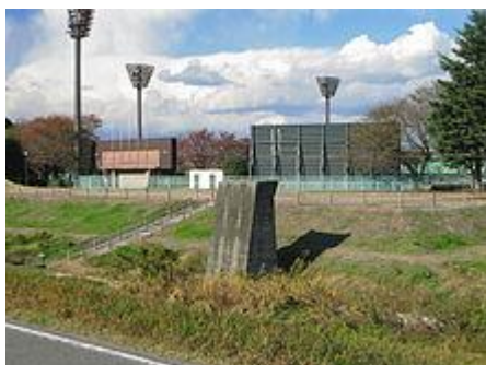
未成線上に今も残る橋脚（群馬県大泉町）。
