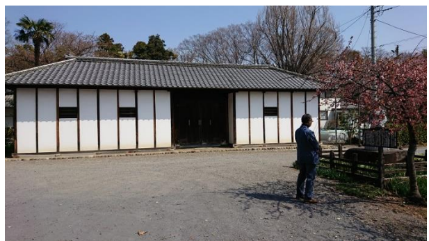
図2 光恩寺に移築された長屋門
