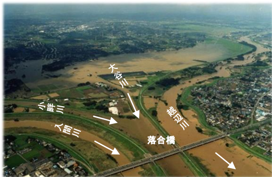
入間川、小畔川、越辺川合流点付近
