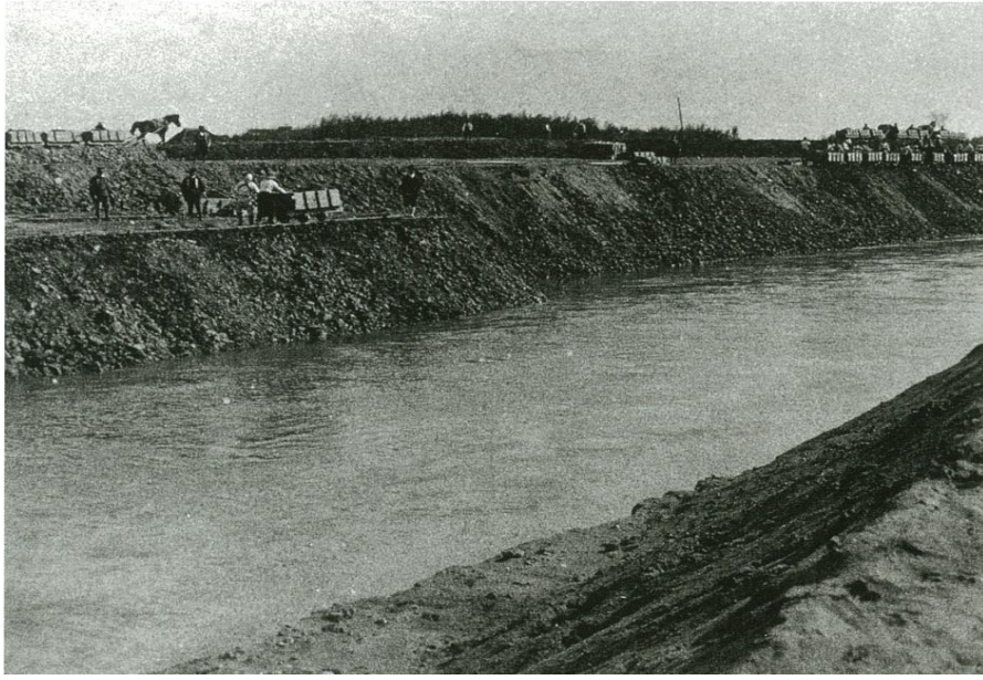
荒川改修工事（現 埼玉県さいたま市馬宮付近） 掘削工事と併せて築堤が行われ、工事には蒸気機関車や馬車・トロッコを使用している様子が見えます。写真は、大正10年頃。
