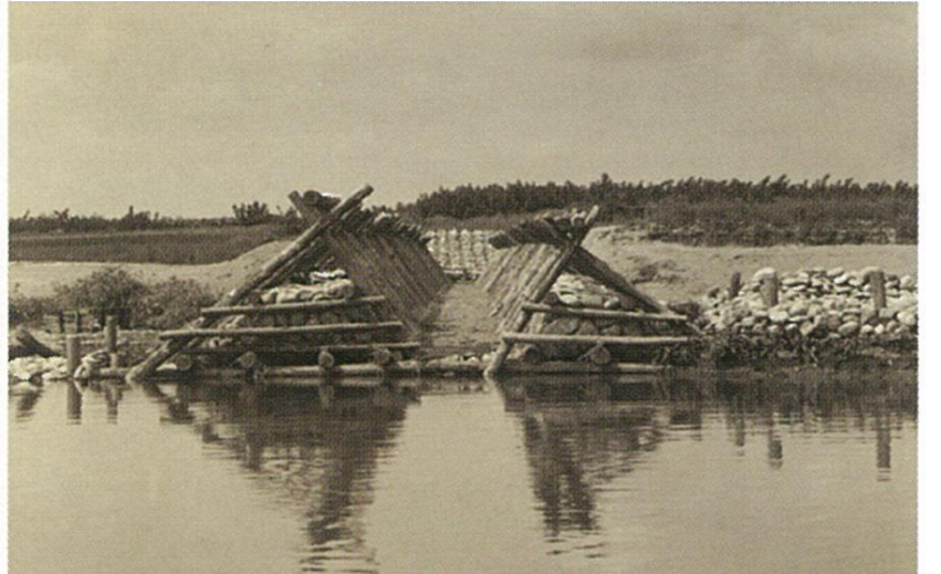
吹上水制護岸（現 埼玉県鴻巣市吹上付近） 写真は昭和10年代頃。
