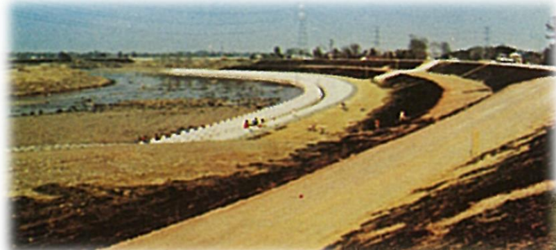
高麗川の堤防改修工事
