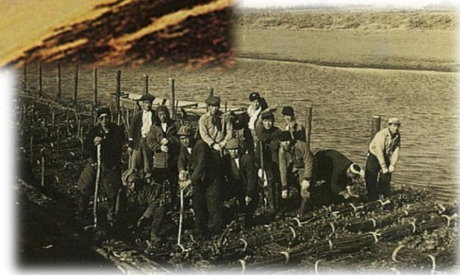
護岸根固工事の様子 粗朶沈床設置作業)
