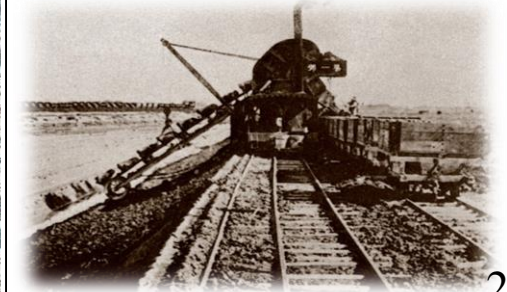
蒸気掘削機を使い水路を掘削
